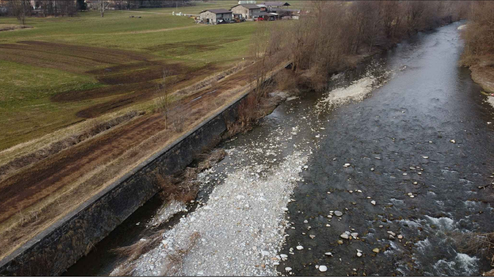
Argine esistente costituito da muro in cls rivestito con pietrame
